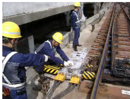
* 転てつ機検査
