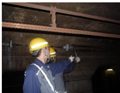
* 電車線路の巡回検査
