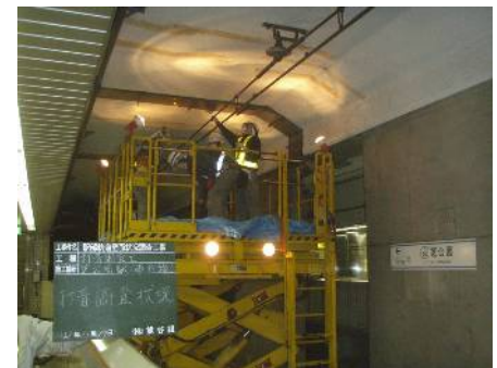
トンネル状況の検査・点検
