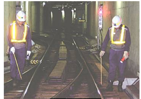
線路巡視・点検
