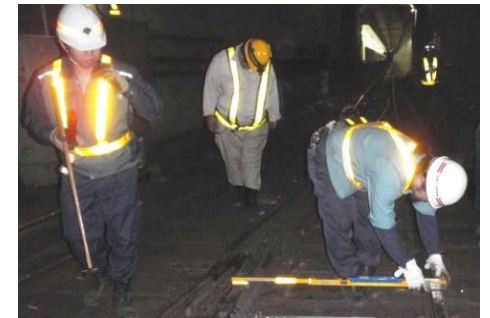
外注工事立会い
