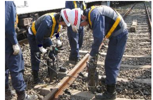
道床碎石突き固め
