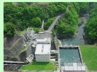
多摩川第一発電所
