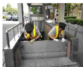
出入口止水板
