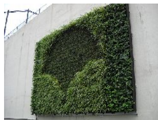
壁面緑化（大島庁舎）
