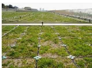
屋上緑化（馬込庁舎）
