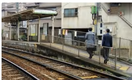
かさ上げしたホームとスロープ
