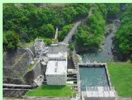
多摩川第一発電所
