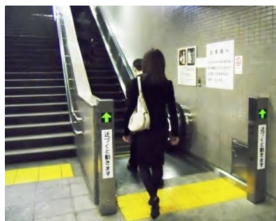
エスカレーターの自動運転
