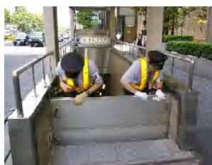
出入口止水板
