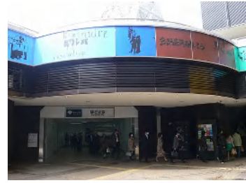
勝どき駅 A 4 出入口
