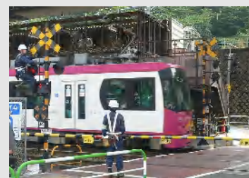
監理団体社員による荒川線の点検
