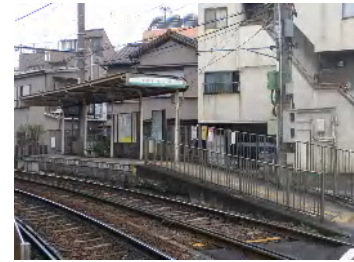
かさ上げしたホームとスロープ
