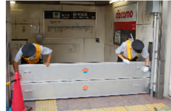
出入口止水板
