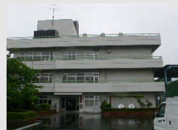
大島車両検査場
