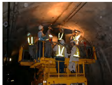
▲トンネル打音調査
