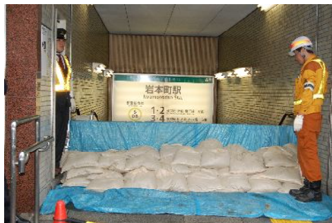
▲浸水防止板・土嚢の設置
