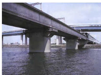
▲耐震補強工事を施した橋脚
