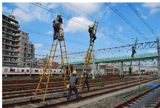
▲電車線復旧作業
