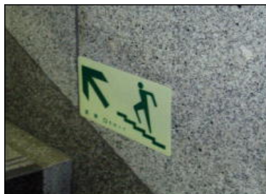
▲蓄光式避難誘導明示物
