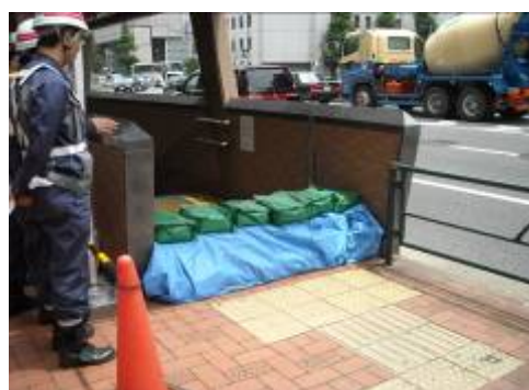
▲土のうの設置
