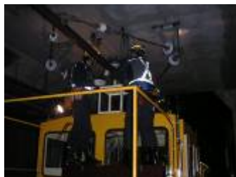
▲架線摩耗検査
