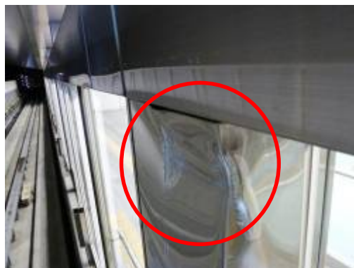
▲ホームドアの損傷
