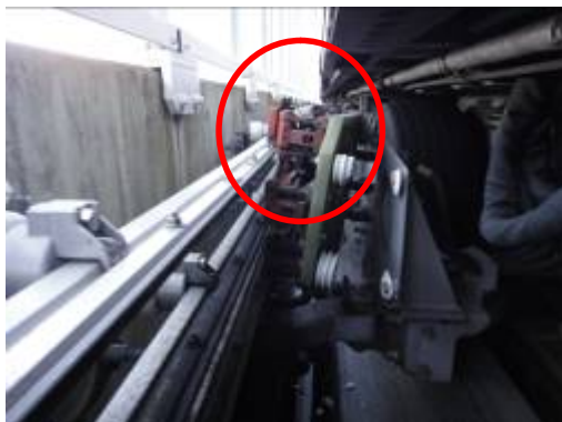
▲架線に乗り上げたパンタグラフ
