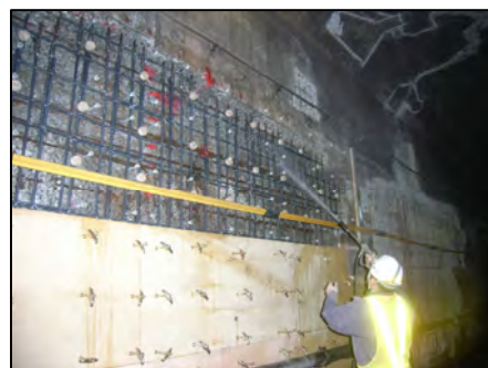
▲塩害を受けた構築の補強工事
