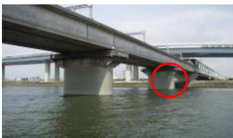
▲荒川・中川橋梁橋脚の耐震補強工事
