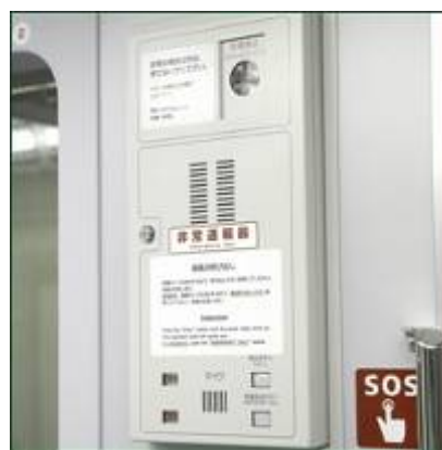
▲非常通報器（日暮里・舎人ライナー）
