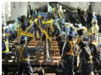
▲ポイント交換工事
