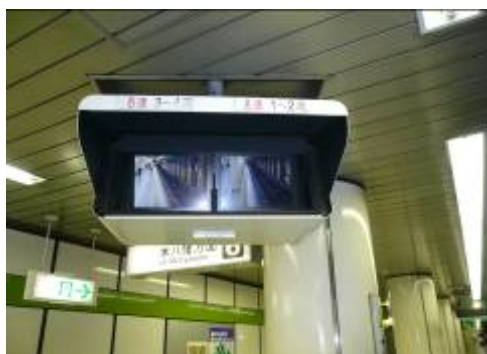
▲ITVモニター装置（新宿線：駅）
