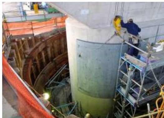
▲荒川・中川橋梁橋脚の耐震補強工事
