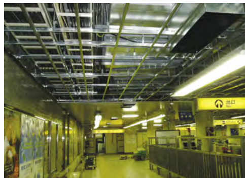
▲駅防災改良工事
