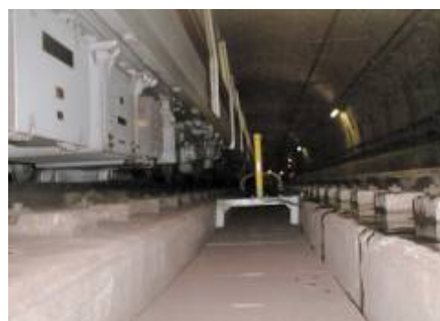
▲限界支障検知器
