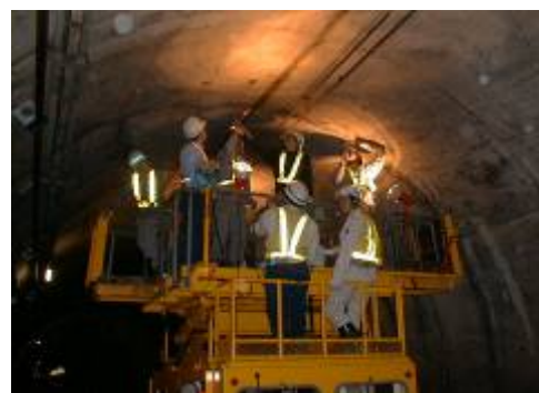
▲トンネル打音調査
