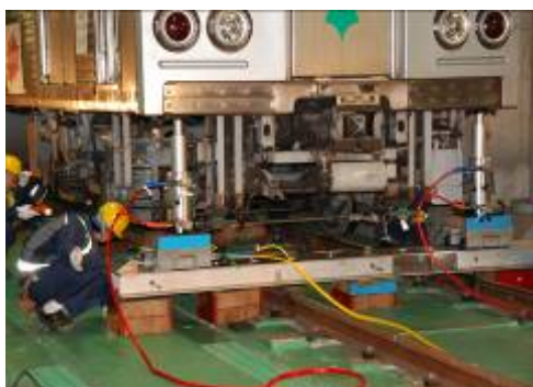
▲脱線台車の復旧
