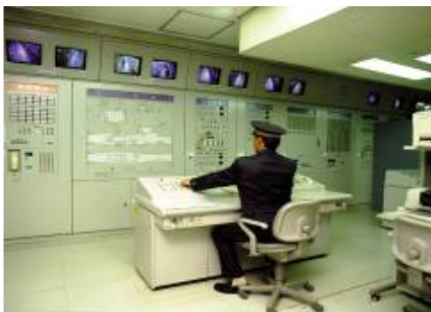
▲防災監視盤 (大江戸線：駅)
