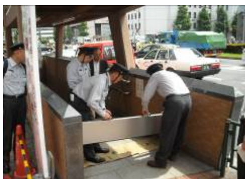
▲止水板の設置
