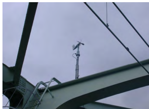
▲新宿線荒川橋梁に設置した風速計
