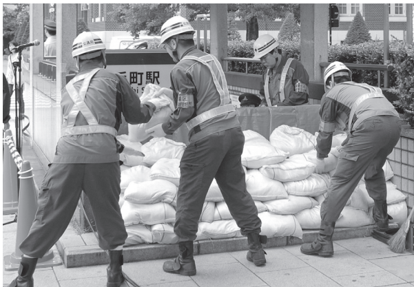
【土のうの設置】
