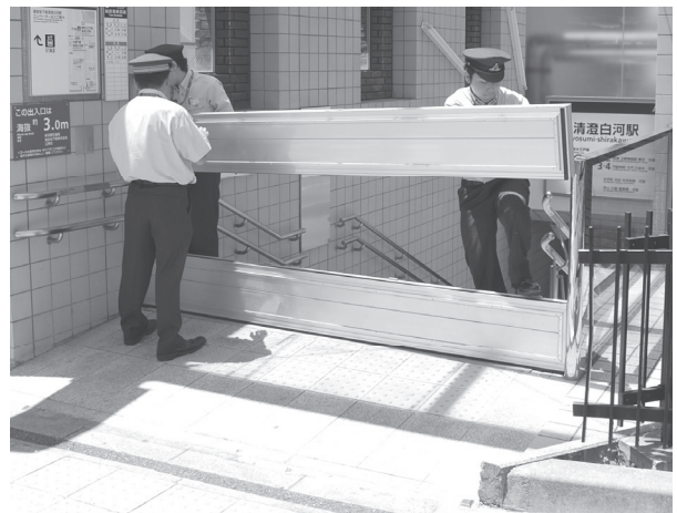
【都営地下鉄駅係員による止水板設置】
