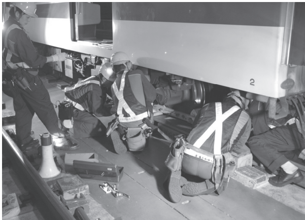
【一軸仮台車の装着作業】
