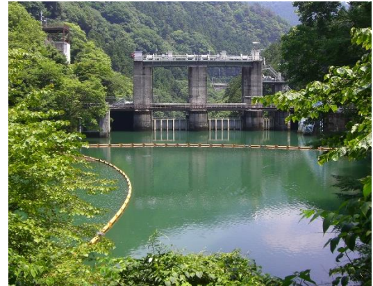
白丸調整池ダム
