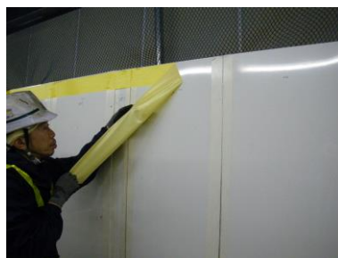
写真２ 仮囲い頂部テープの 取り外し状況・再貼付け状況
