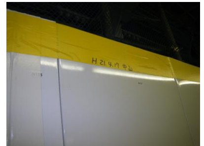
写真２ 仮囲い頂部テープの 取り外し状況・再貼付け状況
