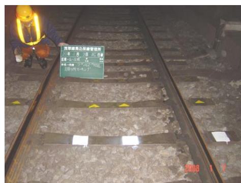
写真2 まくらぎ表示対策後
