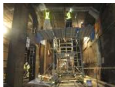
トンネル補修工事の様子
