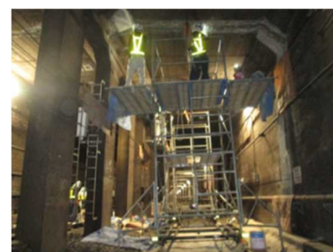
トンネル補修工事の様子
