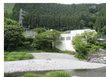
多摩川第三発電所
