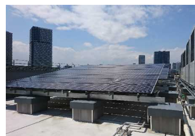
太陽光パネル設置（有明自動車営業所）
