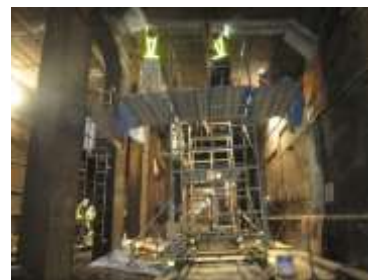
トンネル補修工事の様子
