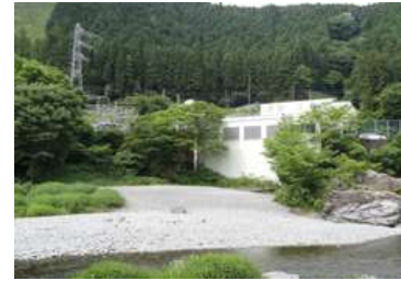
多摩川第三発電所
