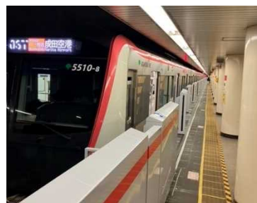
【日本橋駅に整備したホームドア】
