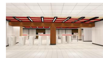
改装工事中(東銀座駅)
