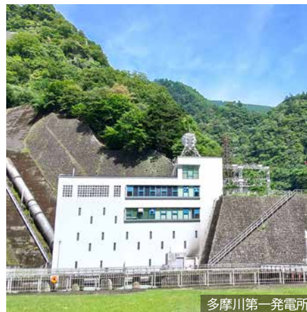
多摩川第一発電所
