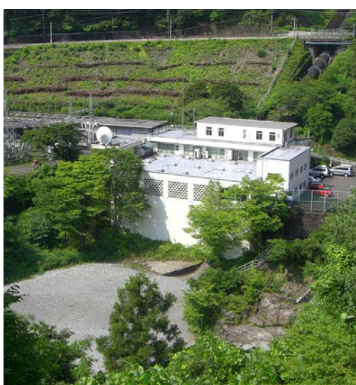
多摩川第三発電所
