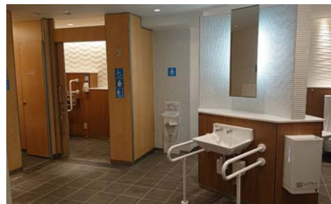
トイレの改修
