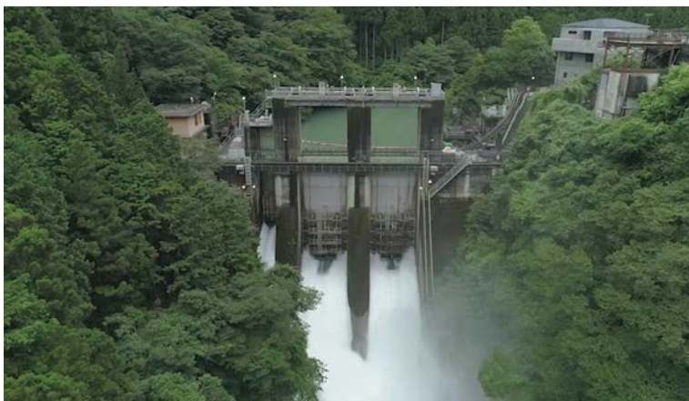
白丸調整池ダム
