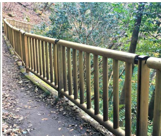
白丸調整池ダム巡視路
