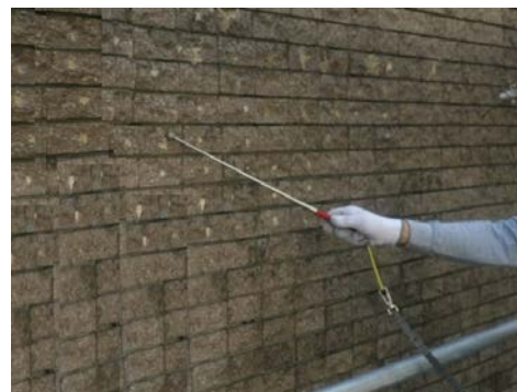
駅出入口等の点検
