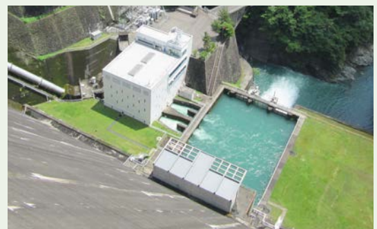
多摩川第一発電所
