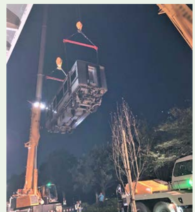
車両の吊り下ろし作業
