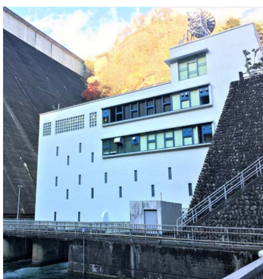
多摩川第一発電所
