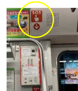
▲非常通報器の案内
