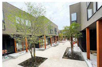
なりわい賃貸住宅（建設中）
