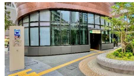
▲再開発地内の新設エレベーター
