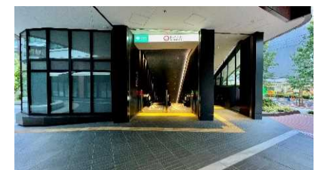
▲再開発地内の新設エスカレーター
