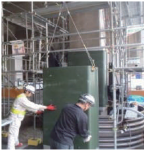
高架部橋脚の耐震補強工事の様子
