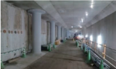
拡張するコンコースの様子（工事中）
