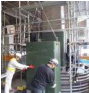
高架部橋脚の耐震補強工事の様子
