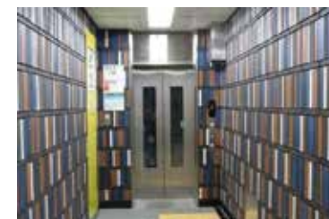
新宿線神保町駅へ増設したエレベーター
