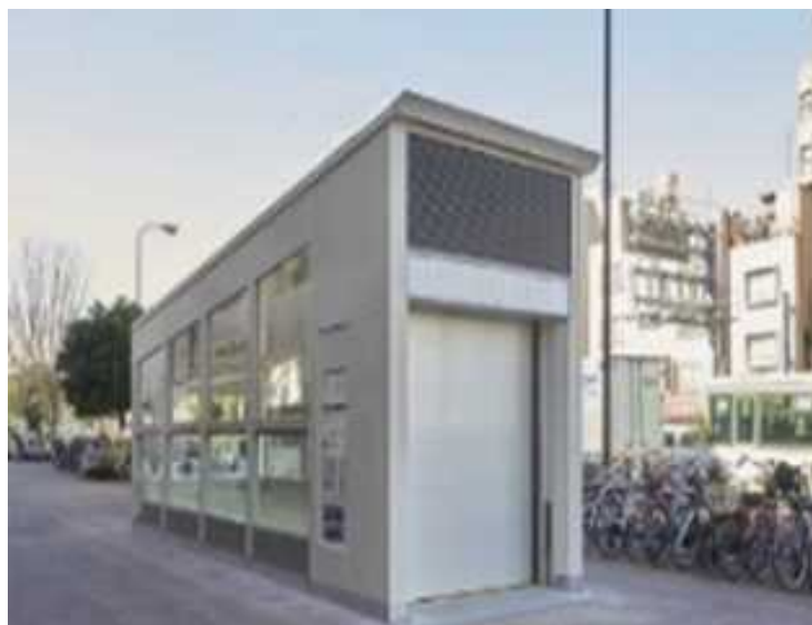
図表 4-7 防水シャッター
