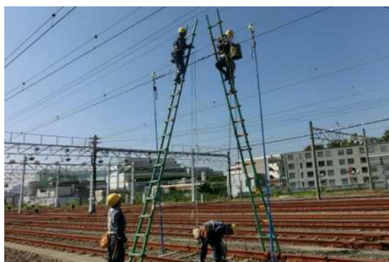
断線した電車線の復旧訓練
