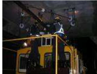
架線摩耗検査
