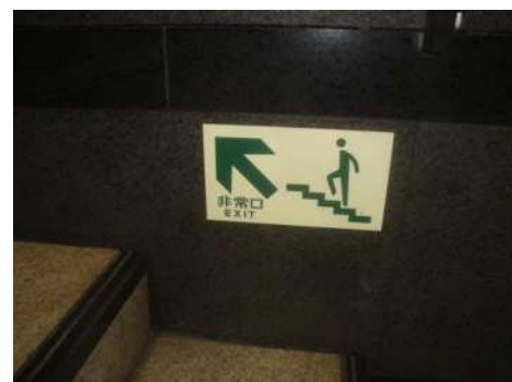
蓄光式避難誘導明示物
