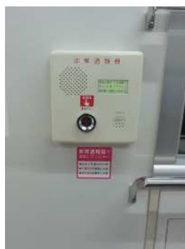
非常通報器（大江戸線）
