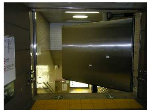
駅出入口の防水扉
