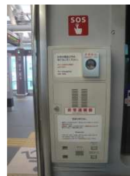
非常通報器（日暮里・舎人ライナー）
