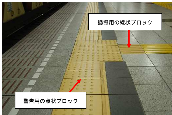
誘導・警告用のブロック
