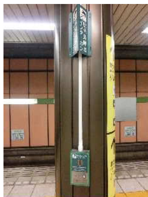
駅係員呼出インターホン
