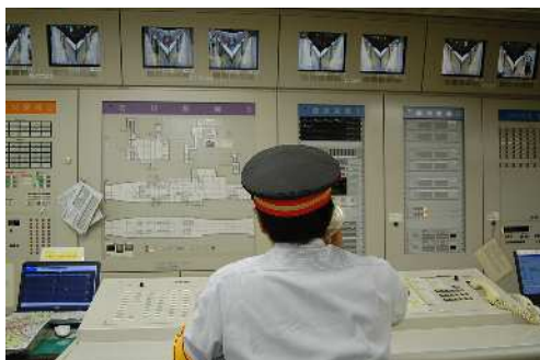
防災監視盤（大江戸線都庁前駅）
