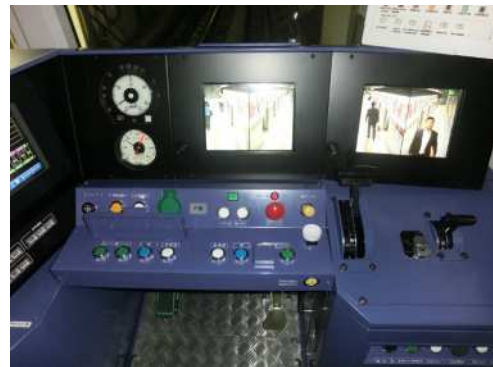
ITV車上モニター装置（大江戸線車両）
