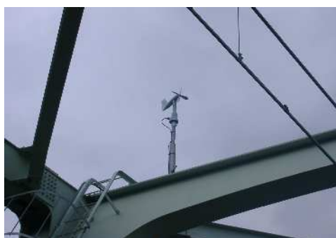
新宿線荒川橋梁に設置した風速計
