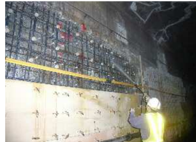
塩害を受けた構造物の補強工事
