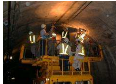
トンネル打音調査
