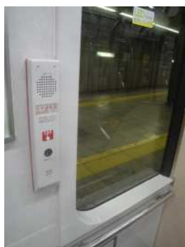
非常通報器（新宿線）
