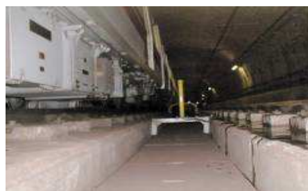
限界支障検知器
