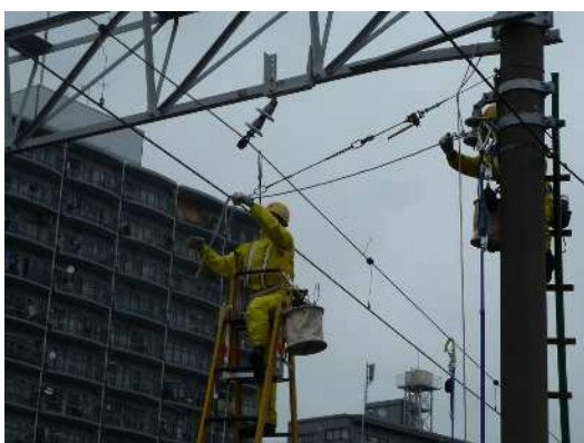
▲断線した電車線の復旧訓練
