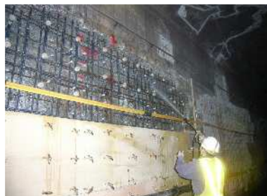
▲塩害を受けた構造物の補強工事
