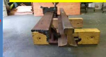
▲脱線防止ガード等をレールに固定
