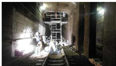
▲はく落対策工事
