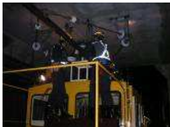
▲架線摩耗検査
