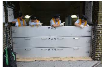
▲止水板の設置訓練
