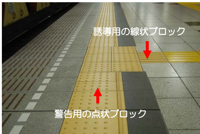
▲誘導・警告用のブロック
