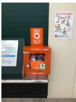
▲水道橋駅（三田線）
