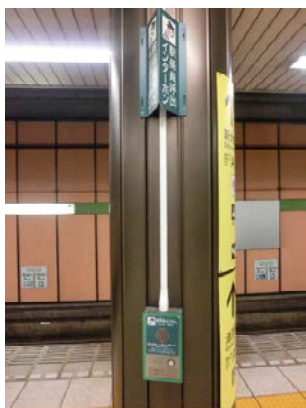
▲駅係員呼出インターホン
