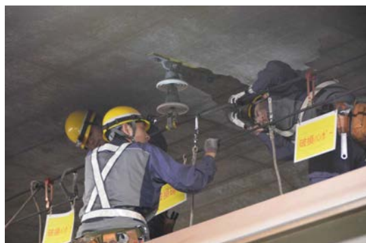
▲電車線の復旧訓練
