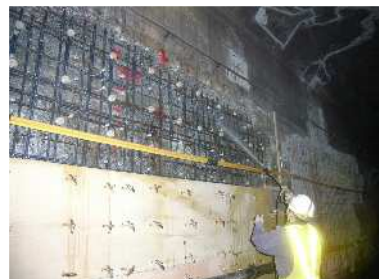
塩害を受けた構造物の補強工事
