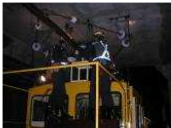
▲架線摩耗検査
