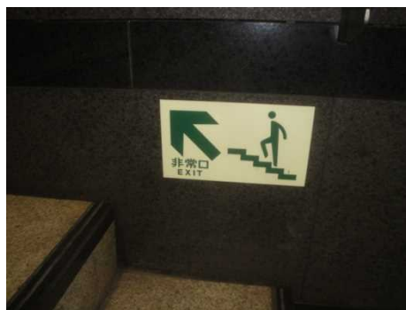
▲蓄光式避難誘導明示物
