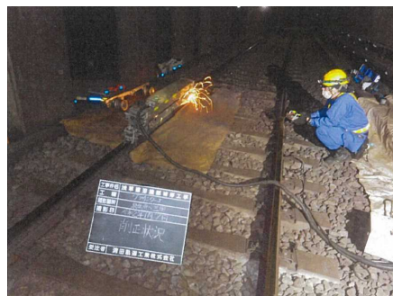
▲溶接部の削正状況
