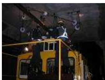
▲架線摩耗検査
