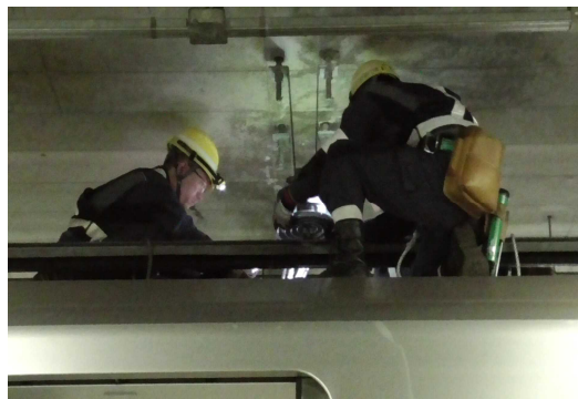
▲電車線の復旧訓練
