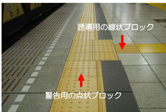
▲誘導・警告用のブロック
