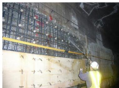
▲塩害を受けた構造物の補強工事
