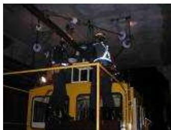
▲架線摩耗検査
