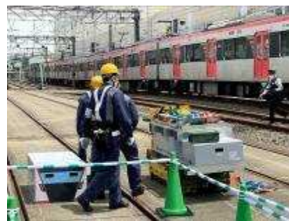
▲クローラー台車による脱線復旧 機材の運搬
