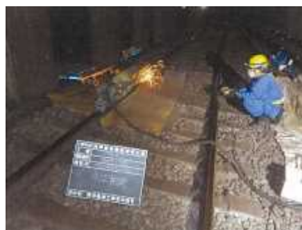
▲溶接部の削正状況
