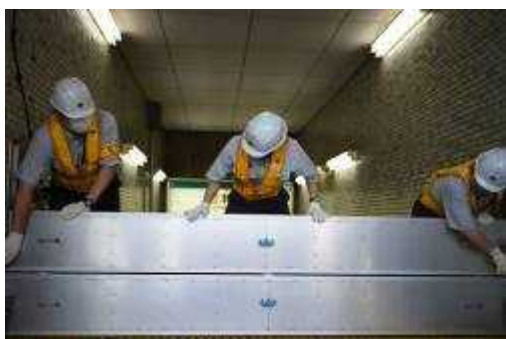
▲防水板設置訓練
