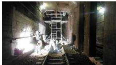
▲剥落対策工事
