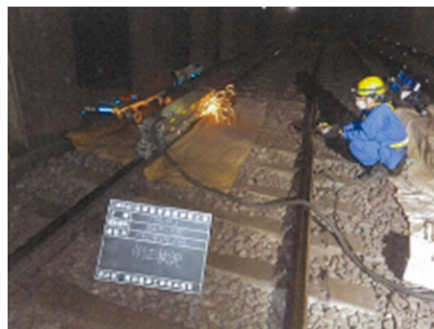
▲溶接部の削正状況
