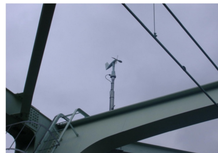
▲新宿線荒川橋りょうに設置している風速計
