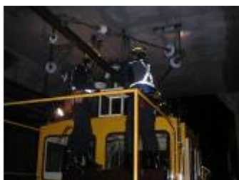
▲架線摩耗検査
