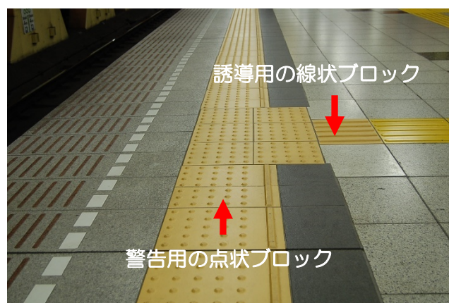
▲誘導・警告用のブロック
