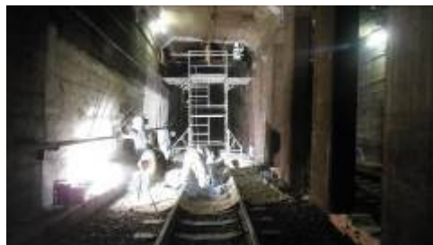
▲剥落対策工事
