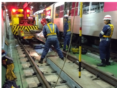
▲リアクションプレート交換訓練
