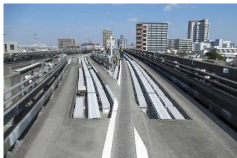
▲ 段差解消設置状況(熊野前)
