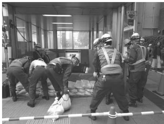
【止水板及び土のうの設置】
