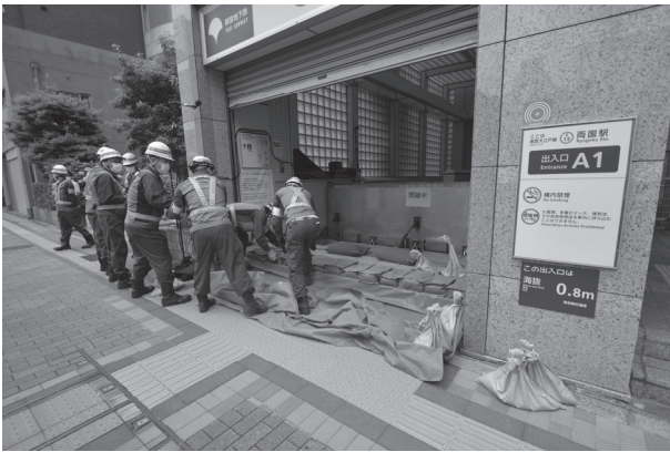
【止水板の設置】
