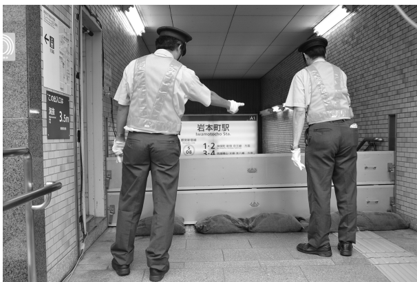
【止水板の設置】
