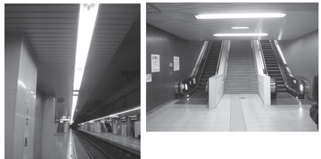
【照明のLED化・エスカレーターの改修・更新】
