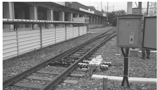
【模擬実習設備】
