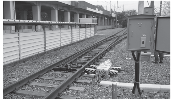
【模擬実習設備】
