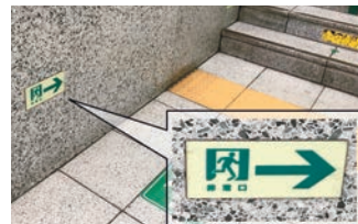
▲蓄光式避難誘導明示物
