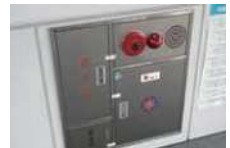
▲自動火災報知設備、消火器、連結送水管設備
