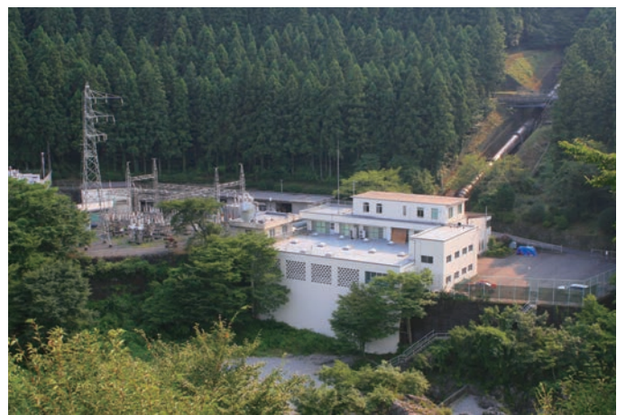
▲多摩川第三発電所
