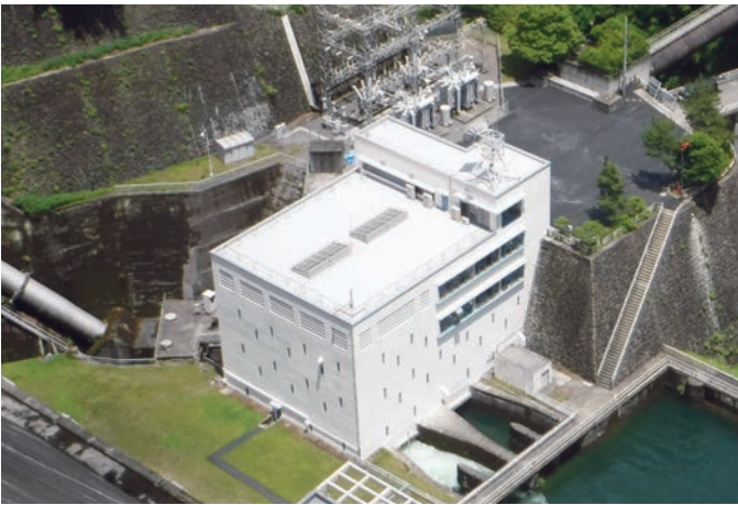
▲多摩川第一発電所
