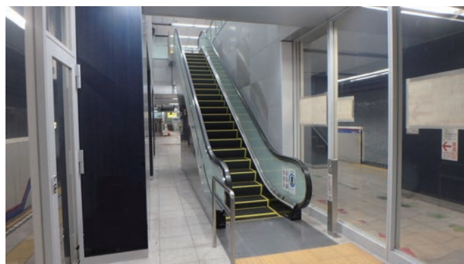
▲エスカレーターの改修・更新による省エネ化
