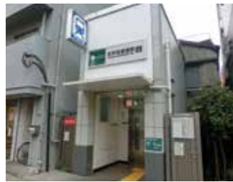
▲地上と改札フロアを結ぶエレベーター
