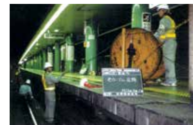
▲光ファイバー工事
