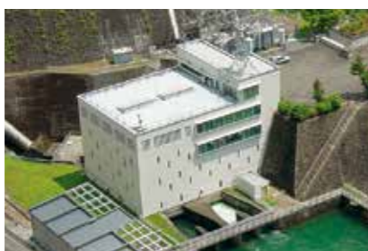
▲多摩川第一発電所
