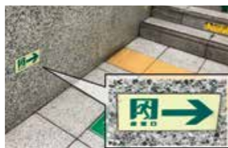
▲蓄光式避難誘導明示物
