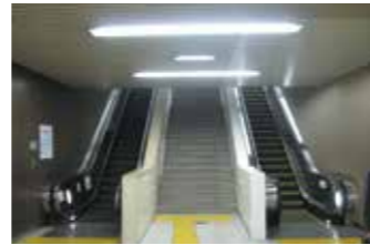
▲エスカレーターの改修・更新による省エネ化
