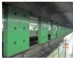
▲耐震補強工事を行った駅の中柱
