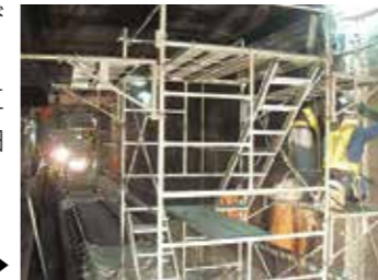
長寿命化工事▶
