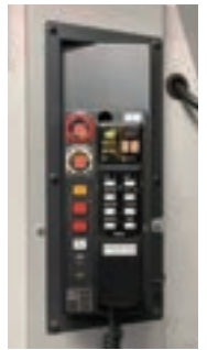
▲列車無線装置
