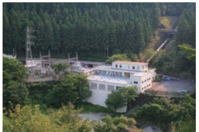
▲多摩川第三発電所
