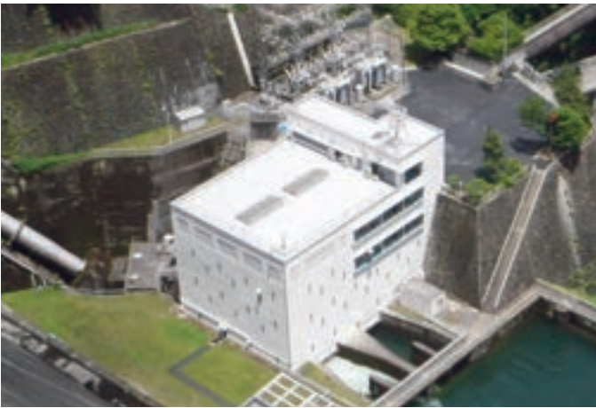
▲多摩川第一発電所
