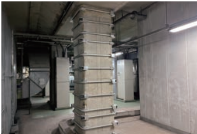
▲耐震補強工事を施した地下部の柱
