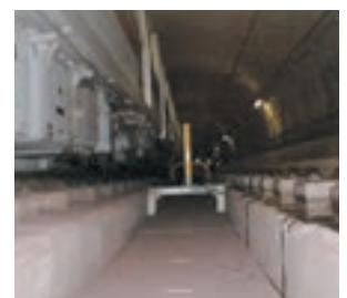
▲限界支障検知器
