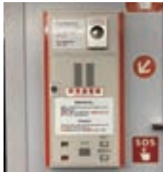
▲非常通報器と非常停止ボタン
