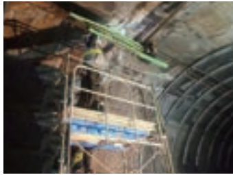
▲長寿命化工事
