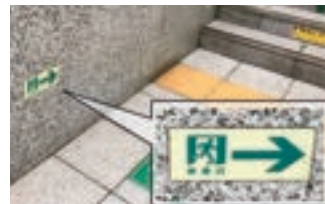
▲蓄光式避難誘導明示物
