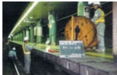
▲光ファイバー工事
