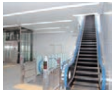
▲エレベーター・エスカレーター（日暮里駅）
