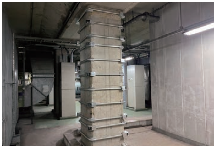
▲耐震補強工事を施した地下部の柱
