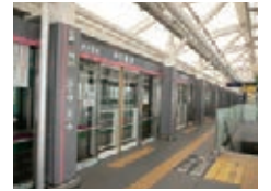
▲ホームドアと視覚障害者誘導用ブロック
