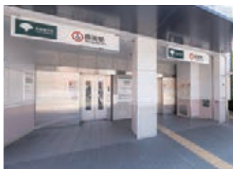
▲地上と改札フロアを結ぶエレベーター
