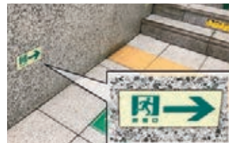
▲蓄光式避難誘導明示物
