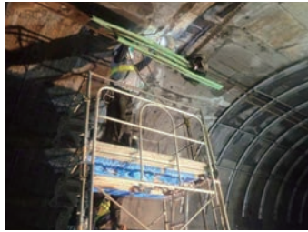
▲長寿命化工事
