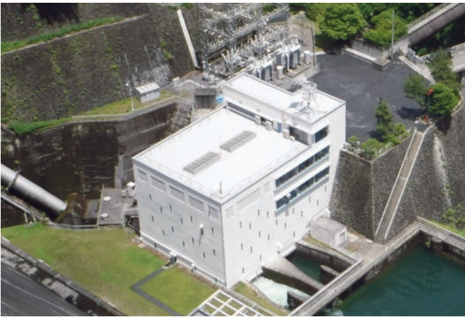
▲多摩川第一発電所
