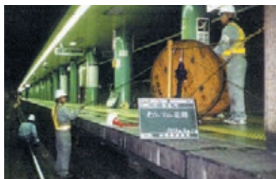
▲光ファイバー工事
