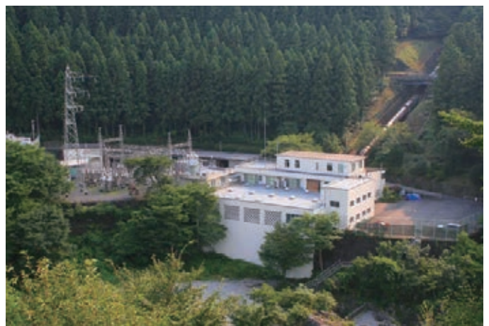
▲多摩川第三発電所
