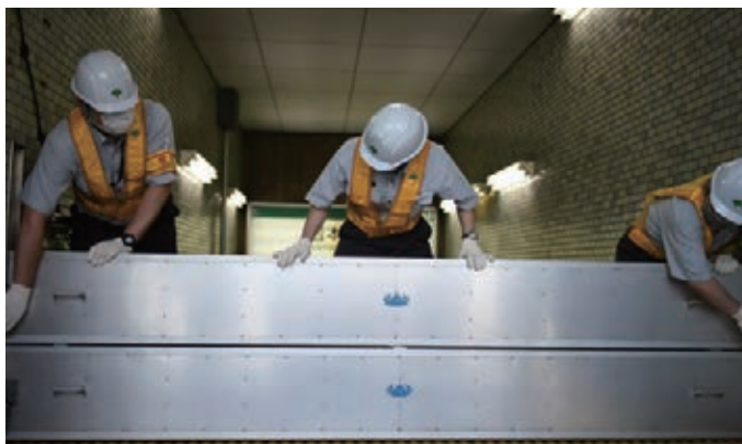
▲止水板の設置訓練
