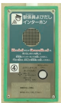
駅係員呼出インターホン▶
