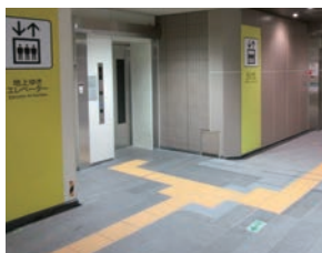
▲誘導ブロック
