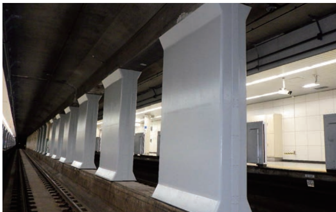
▲耐震補強工事を施した地下部の柱
