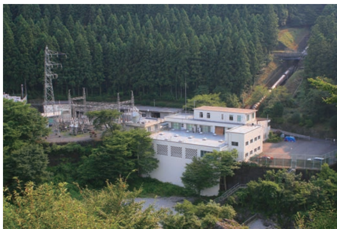
▲多摩川第三発電所
