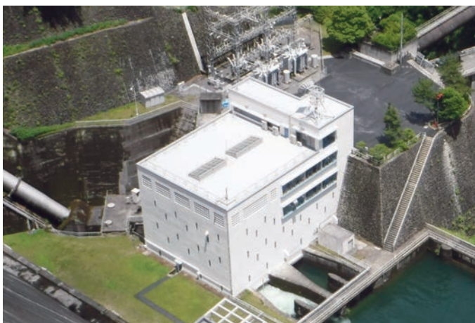
▲多摩川第一発電所
