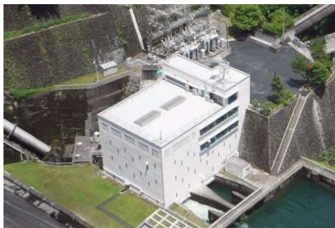
▲多摩川第一発電所
