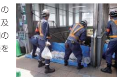
▲止水板及び土のうの設置訓練
