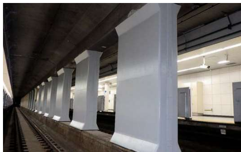
▲耐震補強工事を施した地下部の柱
