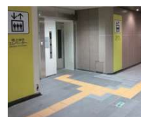
▲誘導ブロック
