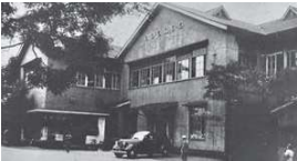
東京市電気局庁舎 (昭和15年)
