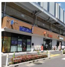
▲西台駅付近高架下
