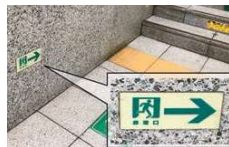
▲蓄光式避難誘導明示物
