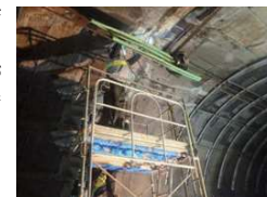
▲長寿命化工事
