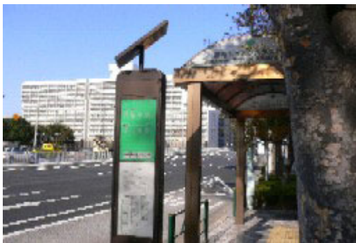
ソーラーシステム付停留所
