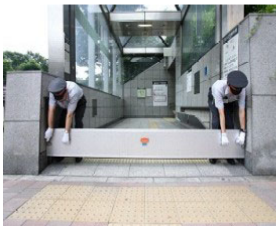
出入口止水板
