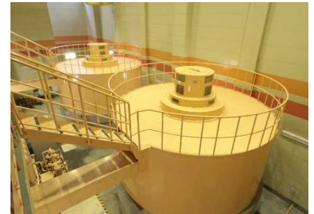
多摩川第三発電所
