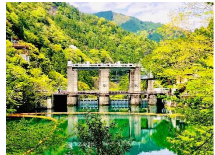
白丸調整池ダム
