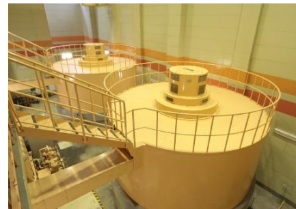
多摩川第三発電所
