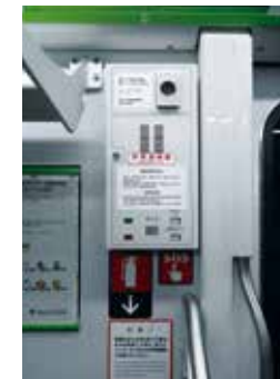
非常通報器・非常停止ボタン
